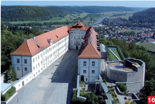
FIG. 16 Il Castello di Hirschberg dopo i lavori del 1760-64.
