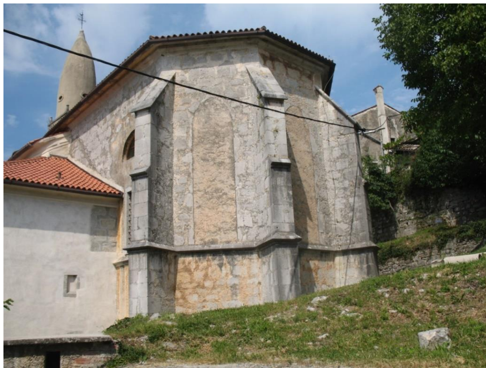
Slika 8.1. Gotski venec zunanjih opornikov in zazidana gotska okna na prezbitteriju vaške cerkve sv. Danijela.
