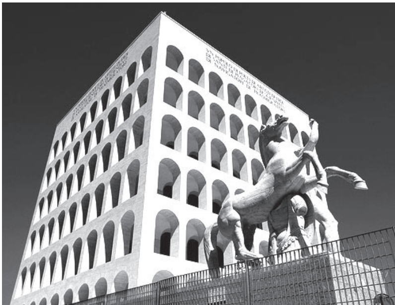
Fig. 10 - Roma, EUR, il palazzo della Civiltà italiana o palazzo della Civiltà del Lavoro, 1938-1942 (G. Guerrini, E. Lapadula, M. Romano)
